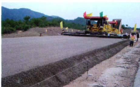
④ 江西景婺黄(常)高速公路水稳层超厚度530mm大宽度12m一次性摊铺
