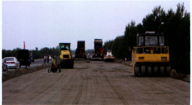
④ 水稳层现行工艺双机分层并幅摊铺工艺
