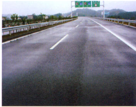
江西景婺黄高速公路雨后观察(现行工艺分层分幅摊铺)
