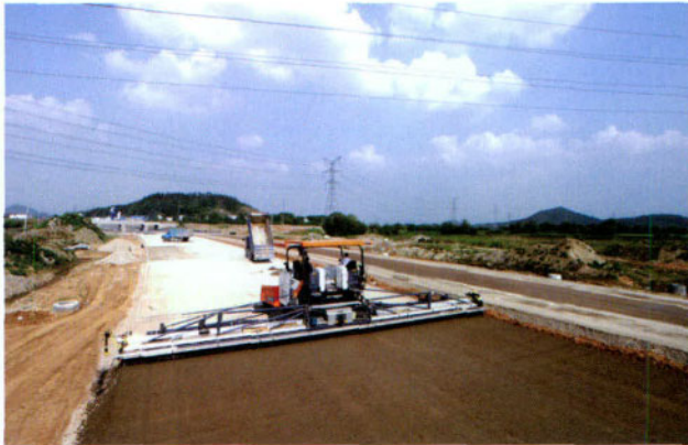
④ 水稳层大厚度宽幅摊铺一次性成型施工
